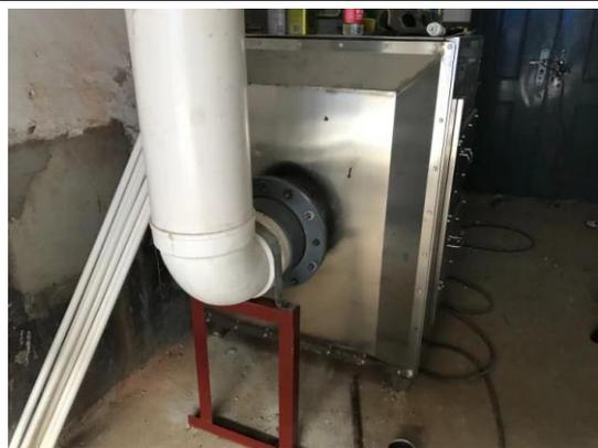
图 4-7 废气处理设施(集气管道)
